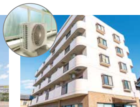
ベランダ、外階段、塀、室外機の上など
