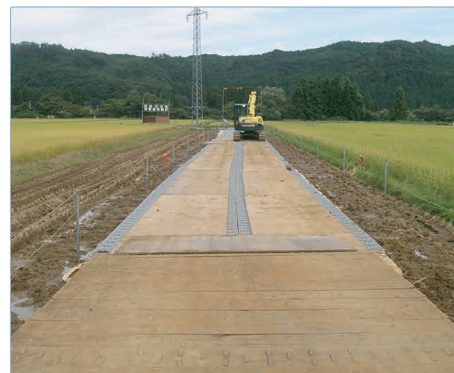
③上面に鉄板を敷設
