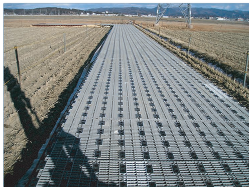
②スペーサーを敷設
