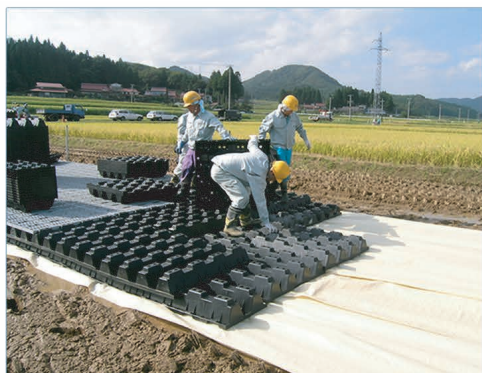
①プラロードを敷設
