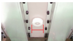
底面裏側排水部分
