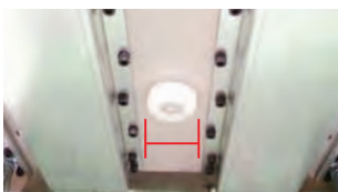
底面裏側排水部分
